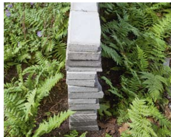
De hoge smalle muren van gebroken 30 bij 30 tegels zijn 90 cm hoog. Hier groeit Dryopteris filix-mas.
